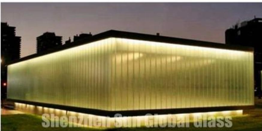
Bild u aus 7 mm eisenarmem U-Profilglas:
