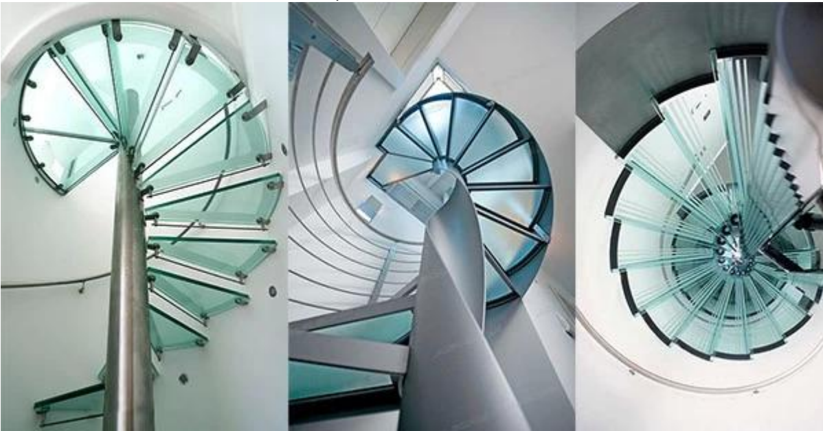
4. caracol con barandilla de vidrio templado curvo 10mm
