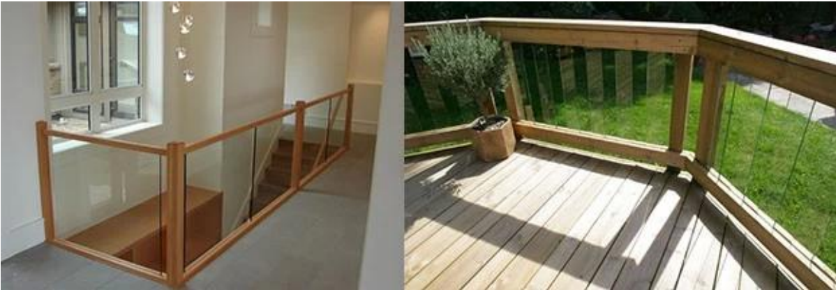
3. madera barandilla enmarcado con vidrio templado:
