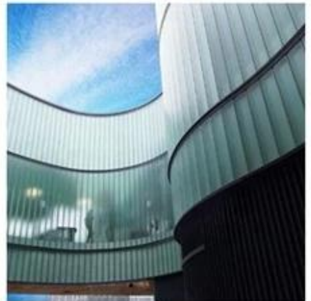
Pict u re de vidro perfilado U de baixo teor de ferro de 7 mm:
