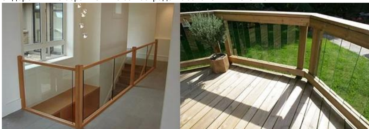
3. деревянные обрамленные балюстрадой с закаленным стеклом:
