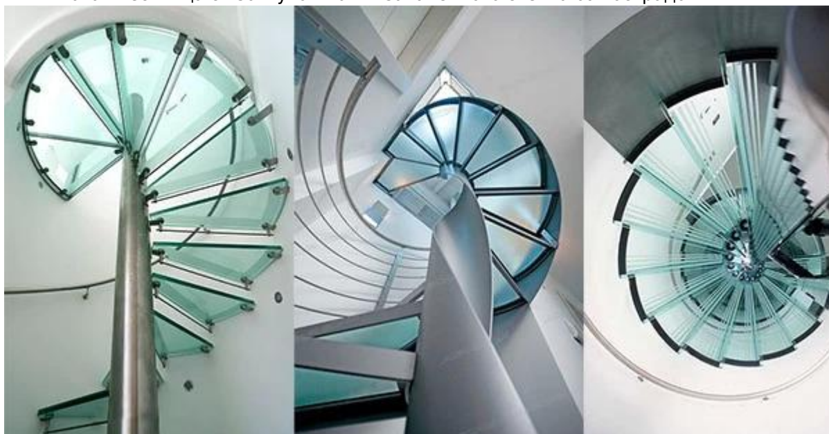
4. винтовая лестница с изогнутой 10 мм закаленного стекла балюстрадой
