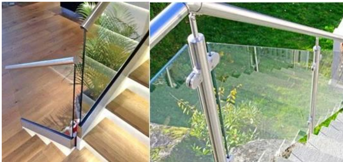
3. деревянные обрамленные балюстрадой с закаленным стеклом:
